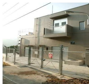
姫戸中継ポンプ場
