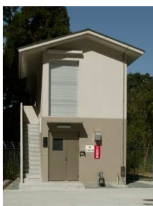
豊野加圧ポンプ棟
