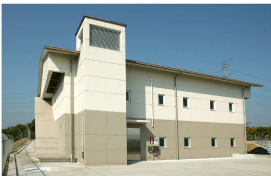
戸馳中継ポンプ場
