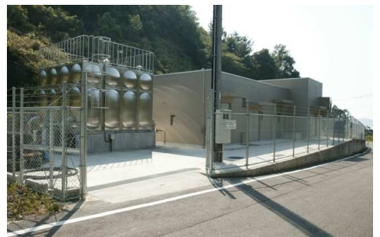
龍ヶ岳中継ポンプ場
