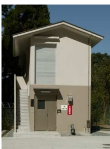
豊野加圧ポンプ棟
