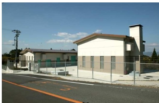
小川中継ポンプ場
