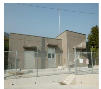
倉岳加圧ポンプ場
