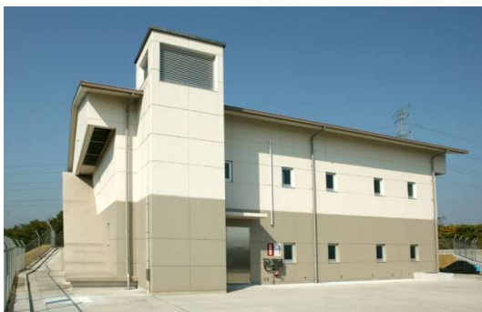
戸馳中継ポンプ場
