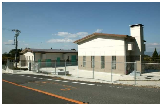
小川中継ポンプ場
