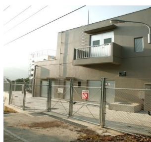
姫戸中継ポンプ場
