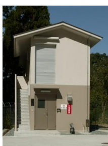
豊野加圧ポンプ棟
