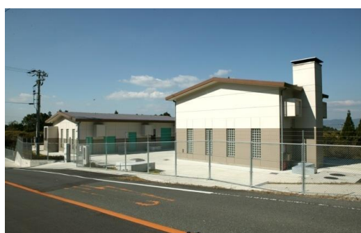
小川中継ポンプ場
