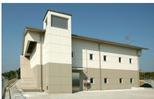
戸馳中継ポンプ場
