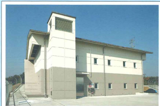
7 戸馳中継ポンプ場(第3接合槽)
