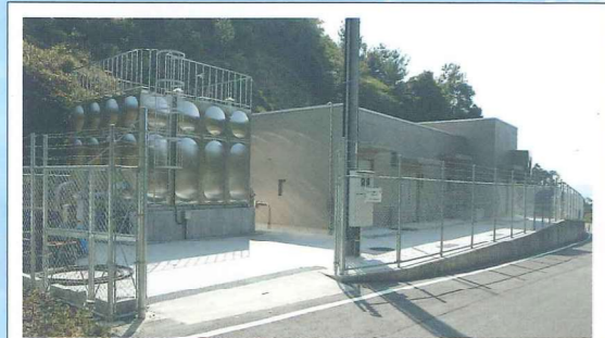
9 龍ヶ岳中継ポンプ場(第4接合槽)
