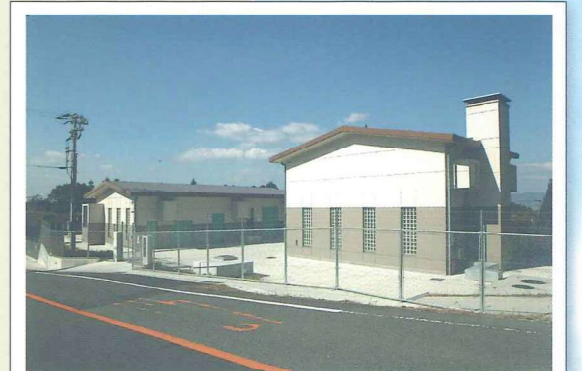
4 小川中継ポンプ場(第1接合槽)
