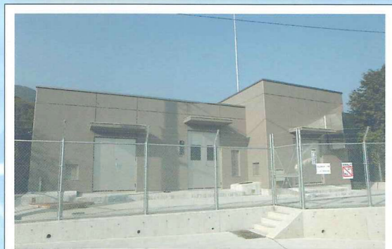
10 倉岳加圧ポンプ場
