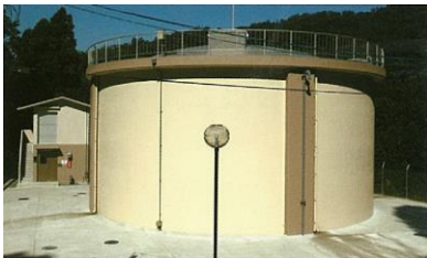
豊野加圧ポンプ棟 小川接合槽 （第2接合槽）
