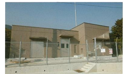
倉岳加圧ポンプ場
