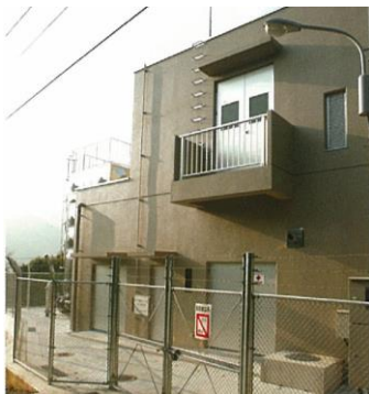
姫戸中継ポンプ場 （第6接合槽）
