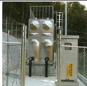
豊野接合槽 （第5接合槽）
