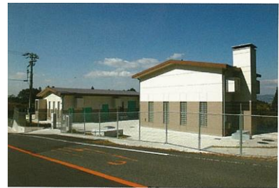
小川中継ポンプ場 （第1接合槽）
