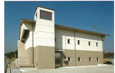
戸馳中継ポンプ場 （第3接合槽）
