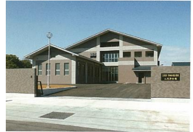
八代浄水場（外観）
