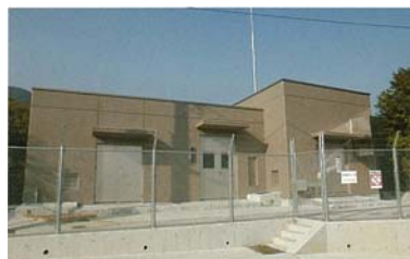
倉岳加圧ポンプ場
