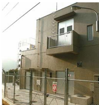
姫戸中継ポンプ場 （第6接合槽）
