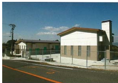
小川中継ポンプ場 （第1接合槽）
