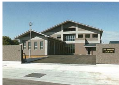
八代浄水場（外観）
