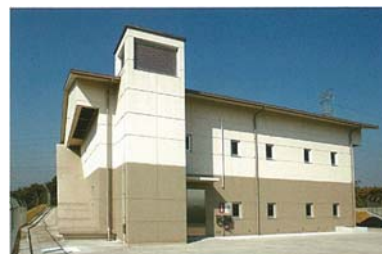
戸馳中継ポンプ場 （第3接合槽）
