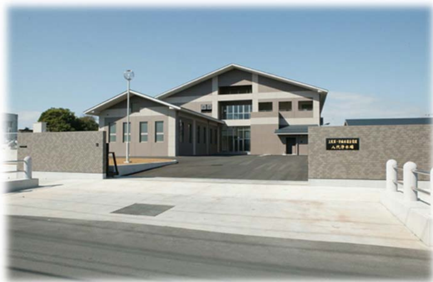
写真：八代浄水場
