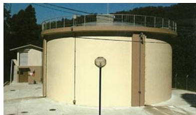
豊野加圧ポンプ棟 小川接合槽 （第2接合槽）
