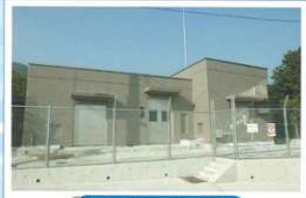
10 倉岳加圧ポンプ場
