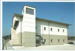
7 戸馳中継ポンプ場(第3接合槽)
