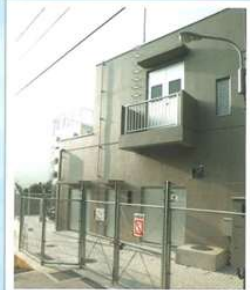
6 姫戸中継ポンプ場(第6接合槽)
