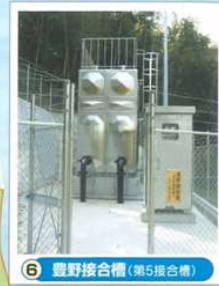
6 豊野接合槽(第5接合槽)
