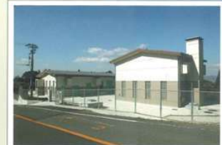
4 小川中継ポンプ場(第1接合槽)
