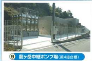
9 龍ヶ岳中継ポンプ場(第4接合槽)
