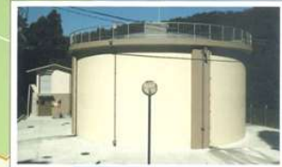
5 豊野加圧ポンプ棟 小川接合槽(第2接合槽)
