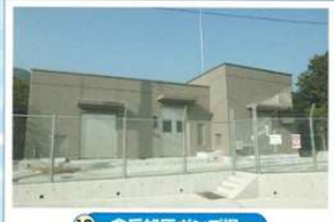
10 倉岳加圧ポンプ場
