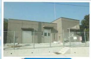
10 倉岳加圧ポンプ場
