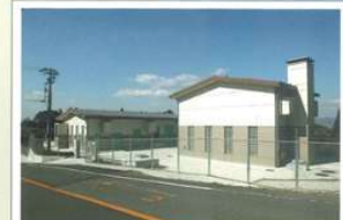
4 小川中継ポンプ場 (第1接合槽)
