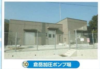
10 倉岳加圧ポンプ場
