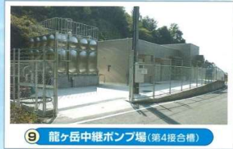
9 龍ヶ岳中継ポンプ場 (第4接合槽)
