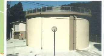
5 豊野加圧ポンプ棟 小川接合槽(第2接合槽)
