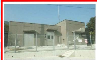
10 倉岳加圧ポンプ場
