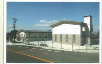
4 小川中継ポンプ場(第1接合槽)
