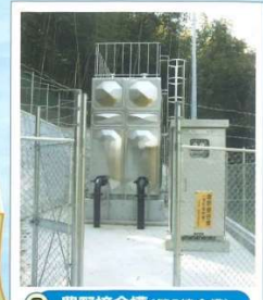
6 豊野接合槽(第5接合槽)
