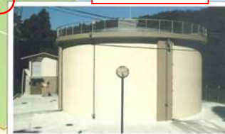
⑤ 豊野加圧ポンプ棟 小川接合槽 (第2接合槽)
