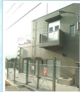
⑥ 姫戸中継ポンプ場 (第6接合槽)
