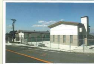
④ 小川中継ポンプ場 (第1接合槽)
