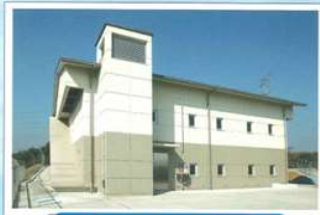
⑦ 戸馳中継ポンプ場 (第3接合槽)
